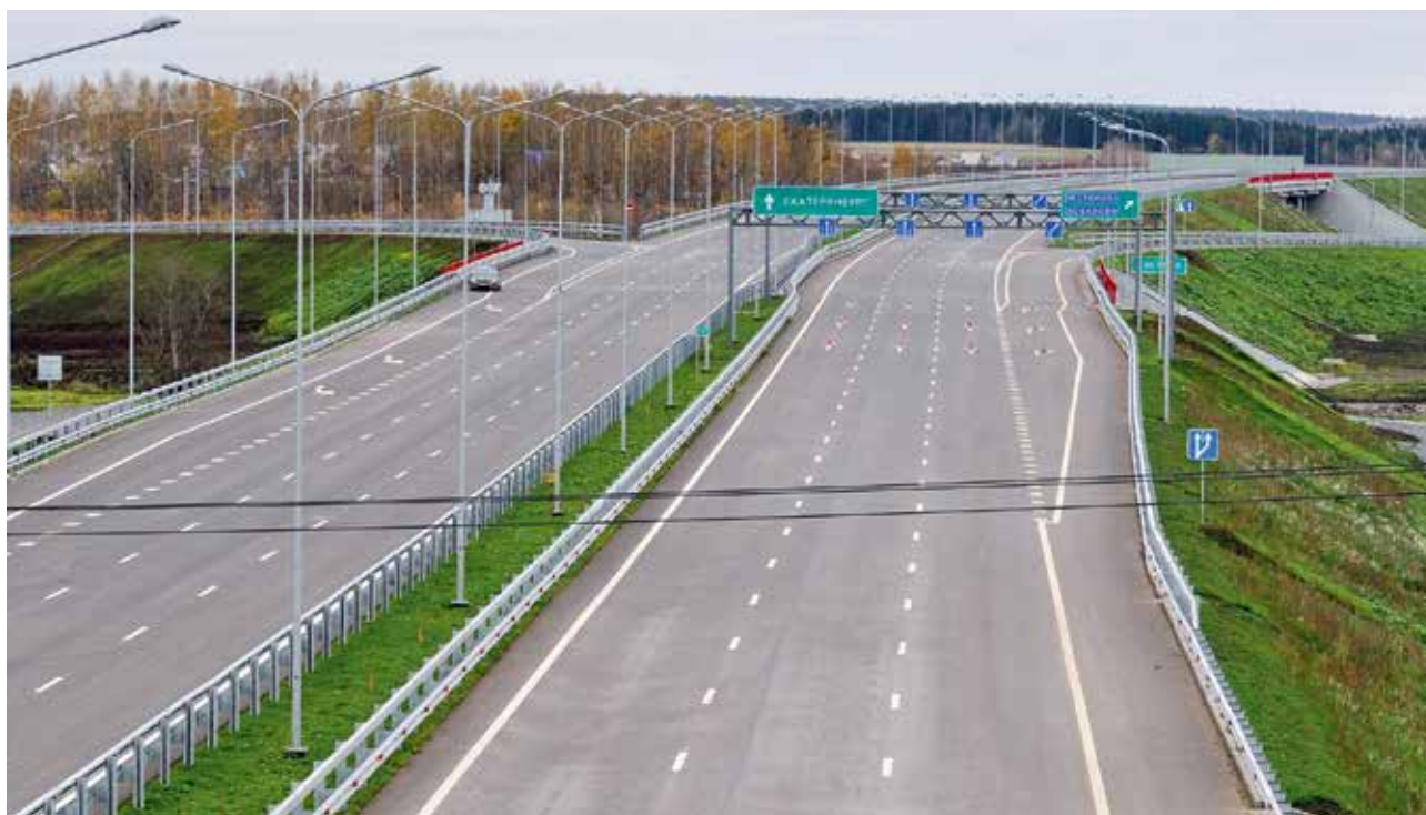
Рис. 5. Ответвление и примыкание в виде параллельных ПСП на современной транспортной развязке автодороги Пермь – Екатеринбург, выполненной в строгом соответствии с требованиями норм [1]
