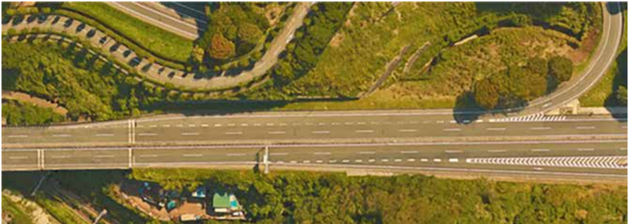
Рис. 6. Различия в трассировании разгонных и тормозных ПСП зарубежной транспортной развязки, устраиваемых в местах разделения и слияния транспортных потоков
